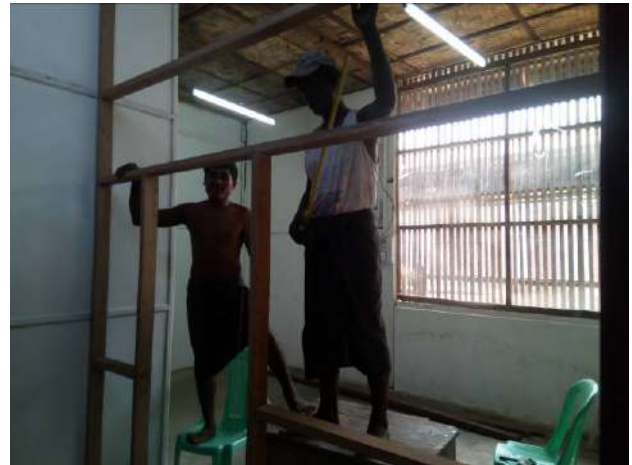
事務所スペース設置工事(2019年3月)
