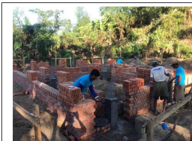
竹産業研修センター建設工事
