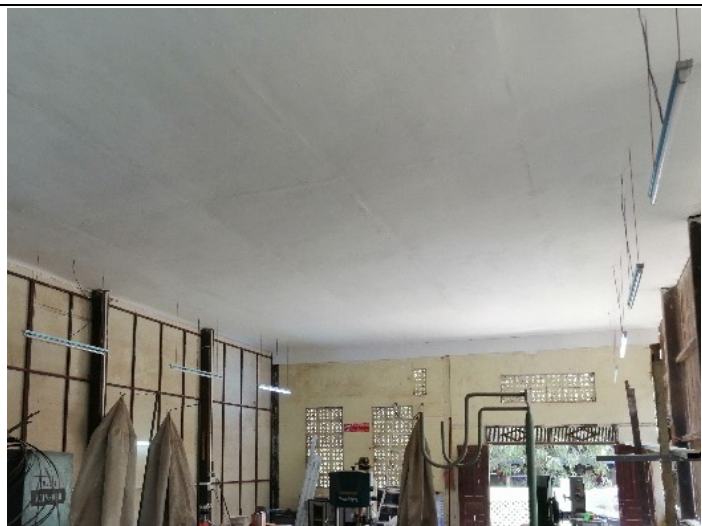
天井を改修し照明設備を設置
