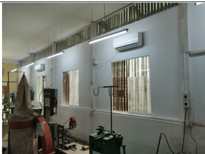
開口部を改修しエアコンを設置
