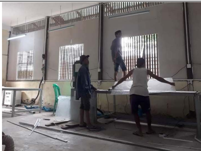
技術センターの開口部にアクリル製の窓障子を設置
